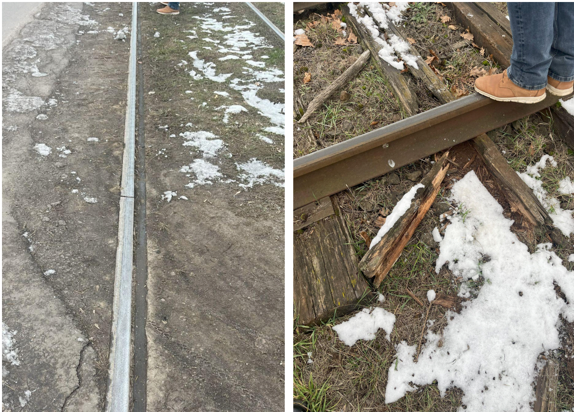
Стан трамвайних колій та шпал у 2025 році (фото А.Гаген)
