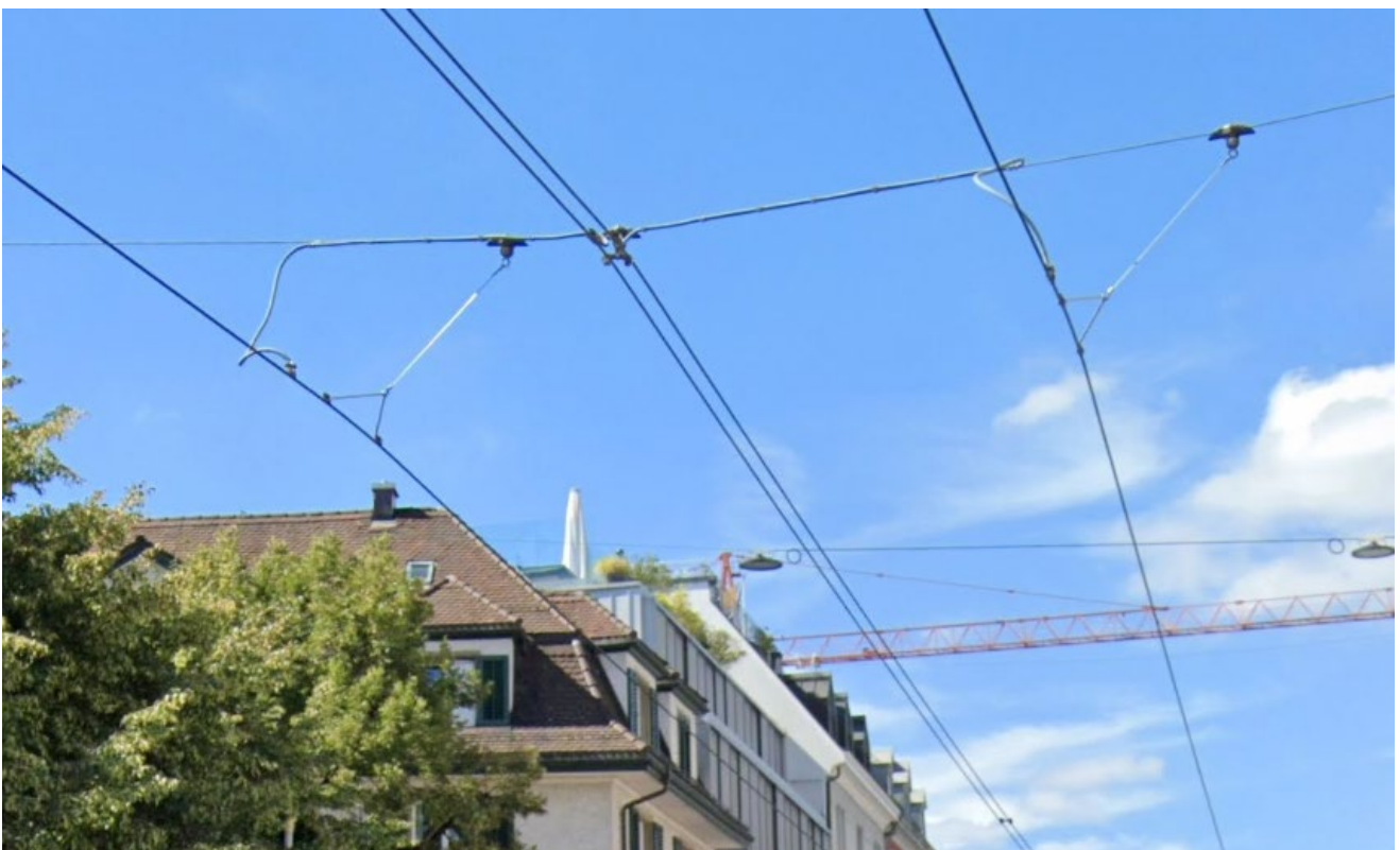
Рисунок 6. На фото із Цюриха, Швейцарія (карти Google [4]), окрім контактних дротів обох напрямків, підвішено підсилюючу дводротову лінію. Вона з'єднана з контактними проводами еквіпотенціальною перемичкою .
