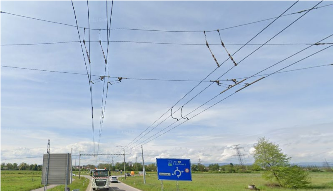
Рисунок 9. На фото з Чеських Будейовиць, Чехія [4], зображено поздовжньо-ланцюгову підвіску тролейбусної лінії. Тут поздовжні несучі троси виконують роль підсилюючої лінії для забезпечення нормальних рівнів напруги та струмів короткого замикання на довгій приміській лінії.
