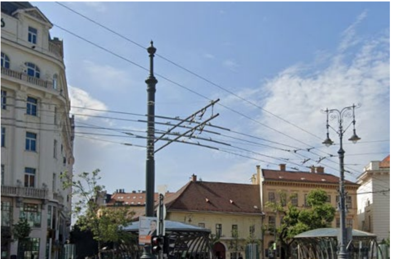
Рисунок 10. На фото з Будапешту, Угорщина [4], зображено підсилюючу мережу (зверху), яка дублює контактну (знизу) для забезпечення нормальної густини струму на односторонній ділянці.
