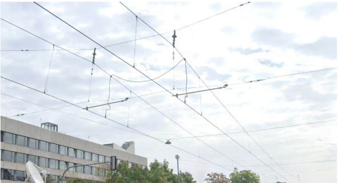
Рисунок 8. На фото з Мюнхену, Німеччина [4], видно поздовжньо-ланцюгову підвіску контактної мережі, де поздовжні несучі троси одночасно виконують роль підсилюючих ліній.
