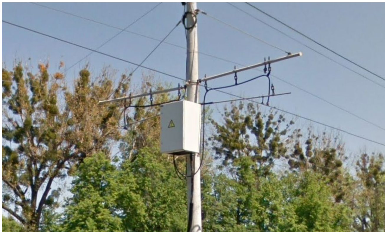
Рисунок 32. На фото з Вінниці [4] бачимо стандартну для України трамвайну лінію. На найновішій ділянці видно лише підключення контактних проводів до шафи живлення, додаткові підсилюючі проводи відсутні.
