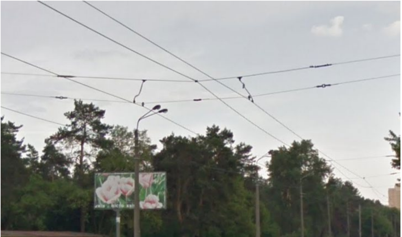
Рисунок 33. Нечастий випадок застосування підсилюючої лінії в Україні. На фото з Києва [4], окрім контактних дротів двох напрямів на нижній поперечині, на верхній підвішено третій, підсилюючий дріт, який з'єднано з контактними еквіпотенціальною перемичкою.
