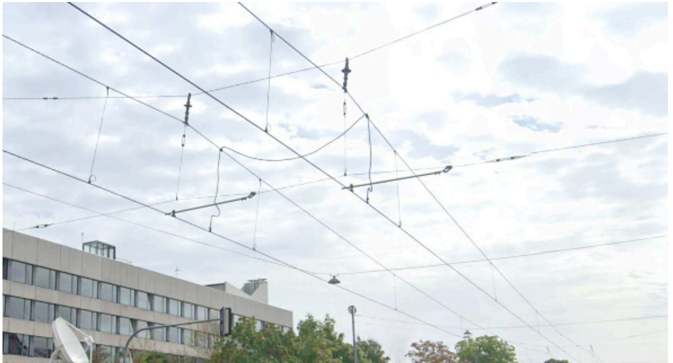
Фото: Мюнхен, Німеччина, поздовжньо-ланцюгова підвіска контактної мережі, де поздовжні несучі троси одночасно виконують роль підсилюючих ліній, джерело: панорами google maps
