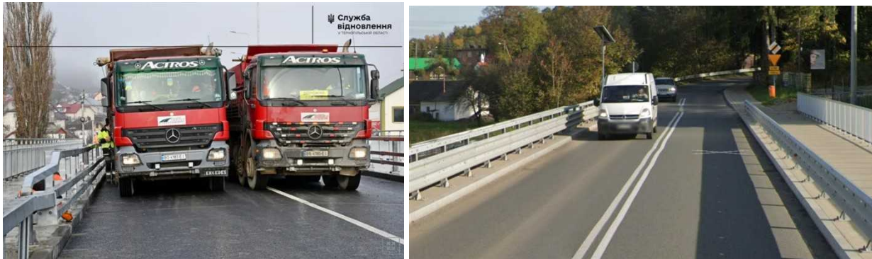
Рис.14. Ширини смуг руху на мостах: 3,75 м в Україні та 3,00 м в Польщі
