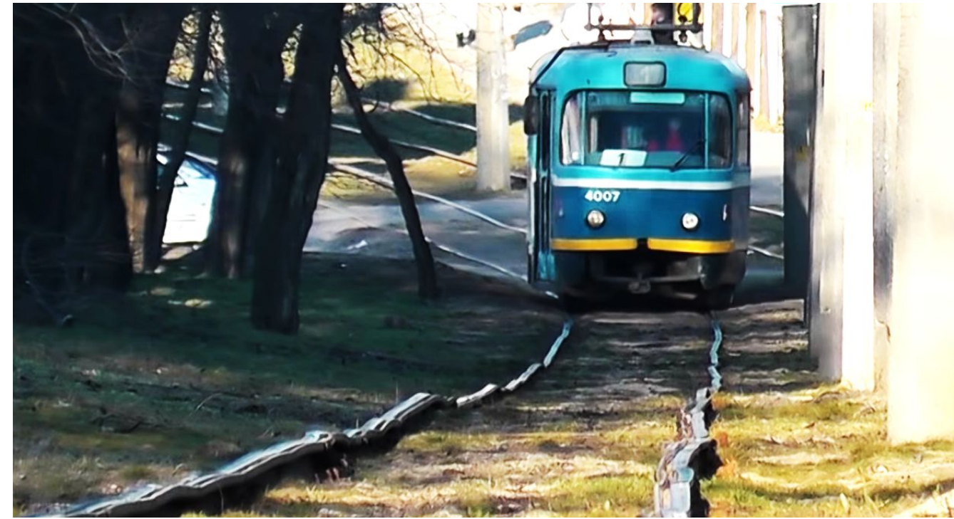
Трамвайні рейки з викривленим профілем в Одесі. Джерело фото: скріншот з відео Yurik203
